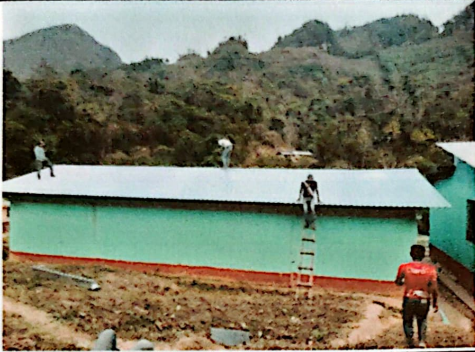
Foto 1: Se puede observar las aulas ya con el nuevo entechado.
