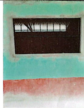
Foto 4: Se puede observar el balcón ya instalado en su totalidad.
