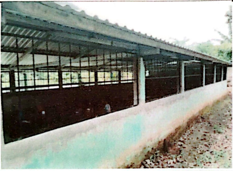
Foto 3: Se puede observar la instalación de los balcones en su totalidad.
