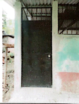
Foto 2: Se puede observar el cambio de puertas de los baños.
